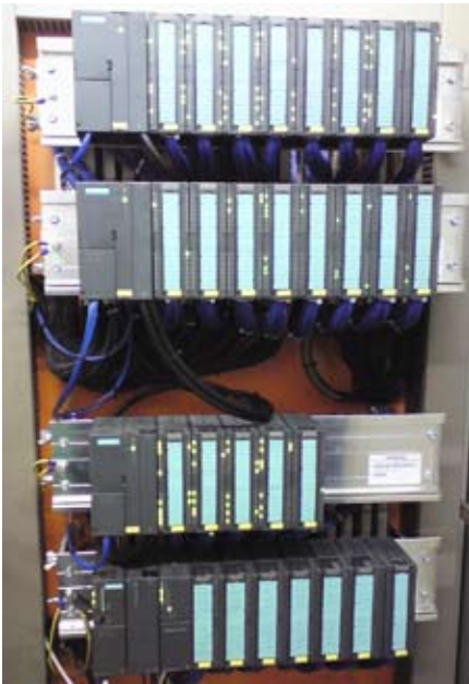
Foto: SPS-Schrank nach Umbau Der Umbau konnte durch AUCOTEAM von geplanten sieben auf zwei Tage verkürzt werden.
