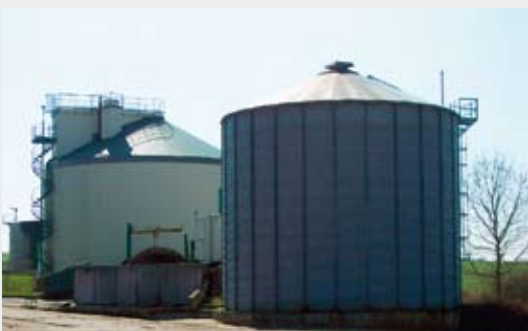
Abbildung 2: Biogasanlage in Neukirchen
