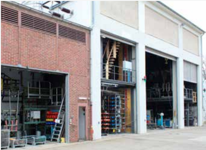
Gebäude mit Prüfhalle
