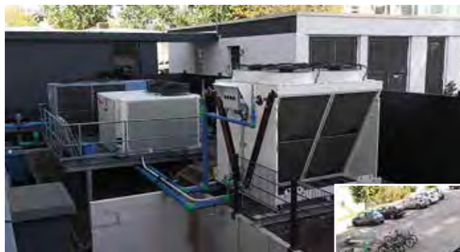
Neu installierter 100 kW Freikühler und 100 kW Rückkühler
