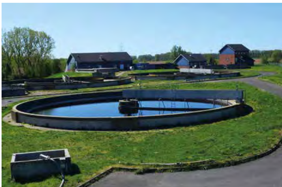
Kläranlage Burg Blumenthal
