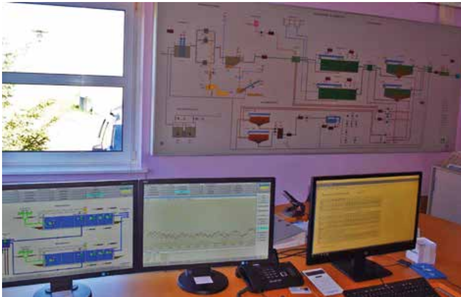
Leitsystem WinCC und Schaubild der Kläranlage
