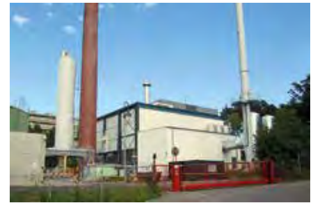
Die Brennstofflagerhalle befindet sich auf dem Betriebsgelände des Fernheizwerks II an der Universitätsklinik Tübingen. (Quelle: Dimo Schmidt)
