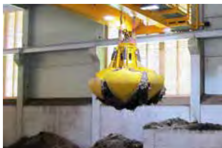
Innenansicht des automatisch betriebenen Brennstofflagers. Der Greifer ist auf dem Weg zum Schubboden.
