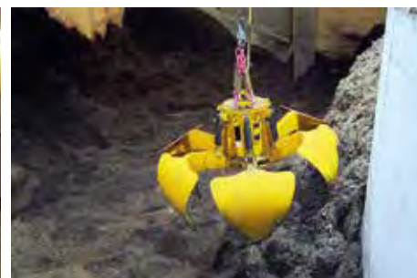
Der Greifer bei der Materialaufnahme
