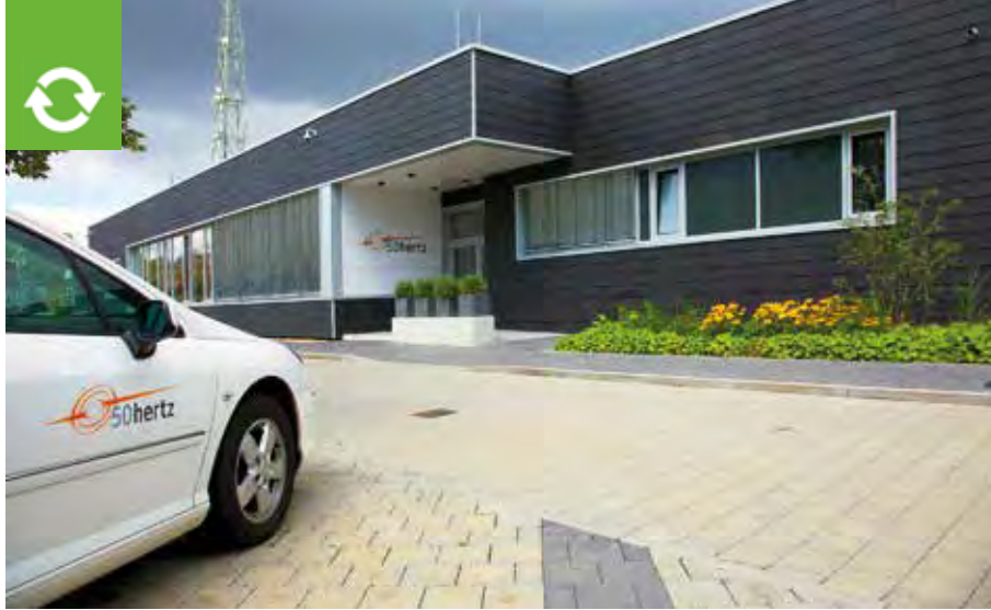
50Hertz-Transmission Control Center in Neuenhagen bei Berlin | Foto: 50Hertz
